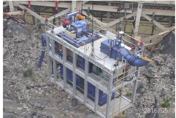
小ガレキ吸引状況 撮影：H28.5.30
