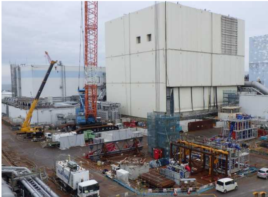
全景(北西面) 撮影：H28.6.24
