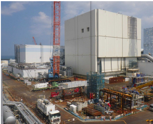
全景(北西面) 撮影：H28.7.11
