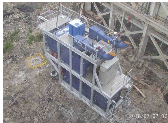
小ガレキ吸引状況 撮影：H28.7.7
