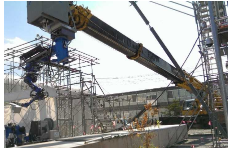
遠隔ロボットによるモックアップ状況
