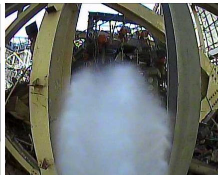
飛散防止剤散布状況
