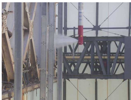
飛散防止剤散布状況（東面）
