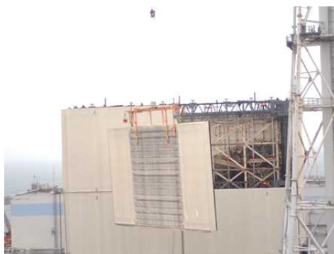
壁パネル吊り下し状況
