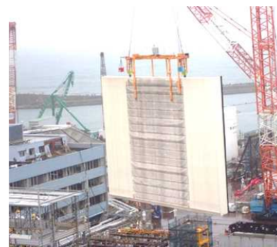
壁パネル吊り下し状況（拡大）
