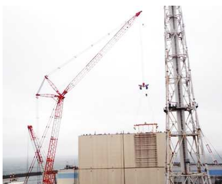
壁パネル吊り上げ前状況
