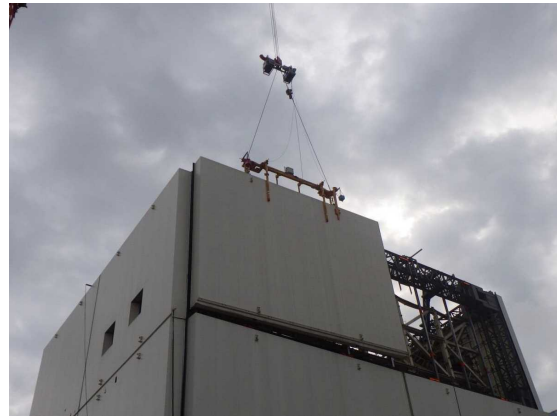
壁パネル取り外し状況（西面）
