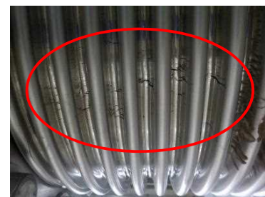
<排ガス補助ブロアB吸込部 (外面)>
