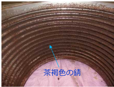
<ベローズ内面> (排ガス補助ブロアA吐出部)
