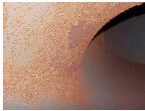
<排ガス補助フロアB入口側煙道>
