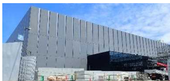
新事務本館（建設中）
