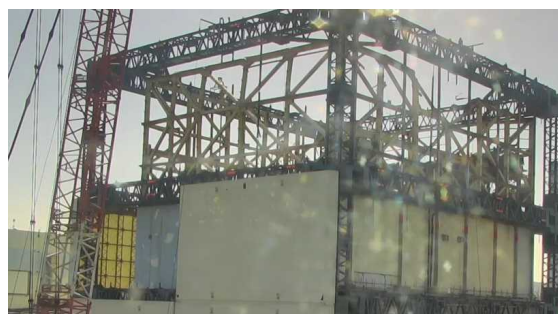
1号機建屋カバー解体工事の作業状況写真（2016年10月25日撮影）
