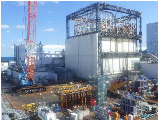
全景(北西面) 撮影：H28.10.24
