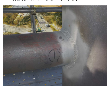
補修後（水平材）
