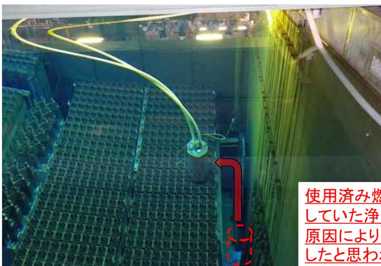
使用済み燃料プール内底部に設置していた浄化フィルタが何らかの原因により、使用済み燃料上へ移動したと思われる。
