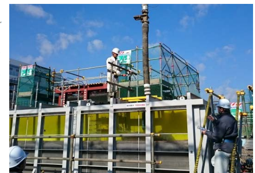
図4 大型ダウンカマ試験の打設状況
