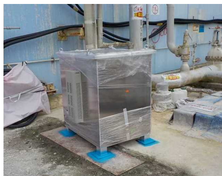
ミュオン測定装置設置 (小型装置, 約1m×1m×高さ1.3m)
