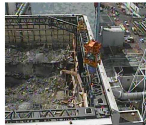
吊り上げ状況（西面）
