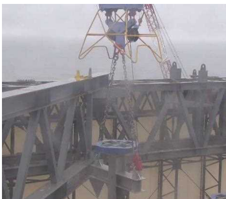
吊り上げ状況（東面）
