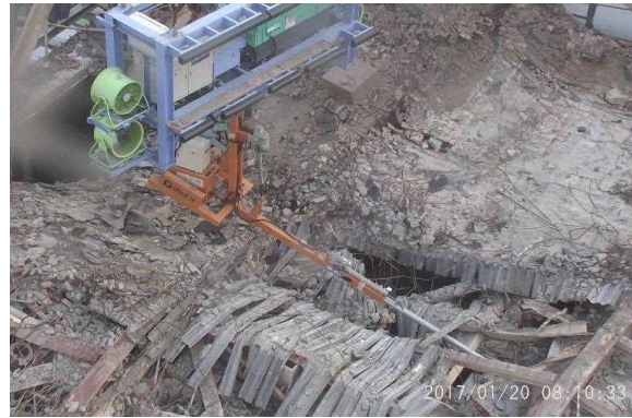
能動スコープでのオペフロ調査（崩落スラブ下）
