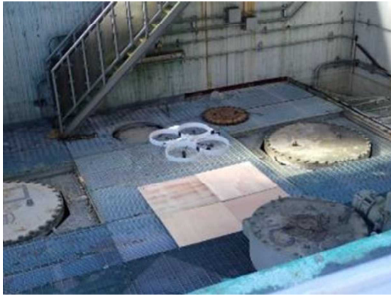
① 3号機 逆洗弁ピット
