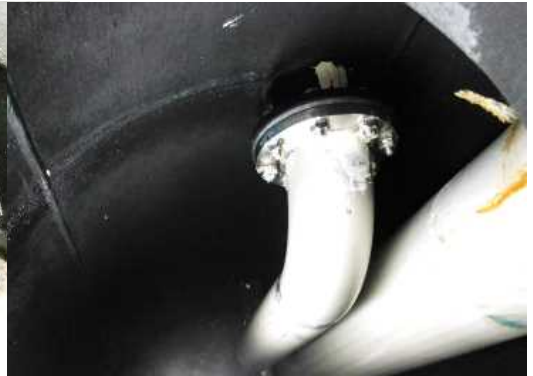
共沈タンク(B)内面の状況 (H28.1) 【ライニングに剥離なし】
