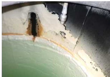
共沈タンク(C)内面の状況 (H29.2) 【ライニングに剥離なし】
