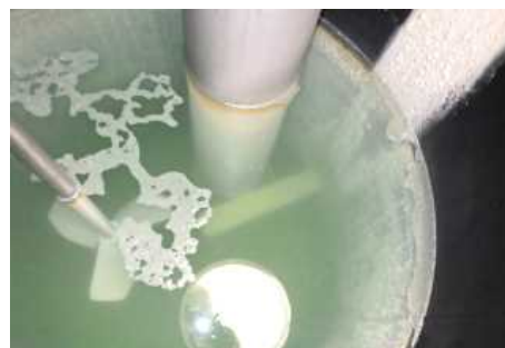
供給タンク(C)内面の状況 (H29.2) 【ライニングに剥離なし】
