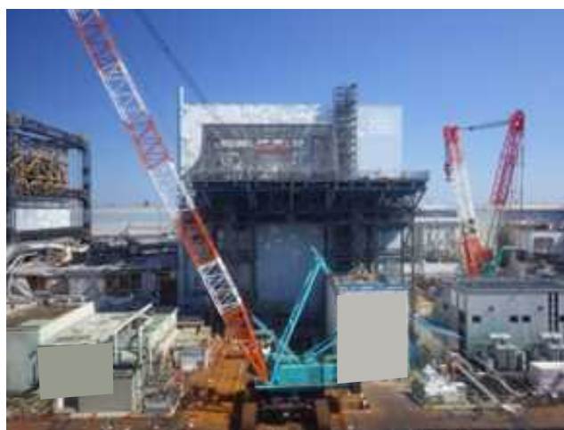
写真③ 2号機原子炉建屋 前室設置状況（全景、2017.3.11撮影）
