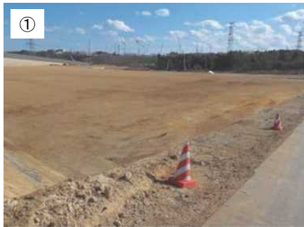
現場状況写真
