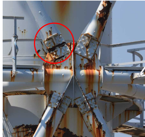
東側(GL+45m付近)
