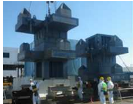
カバー柱改造 撮影：H29.6.17
