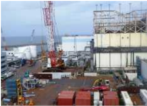
工事エリア全景 撮影：H29.6.26
