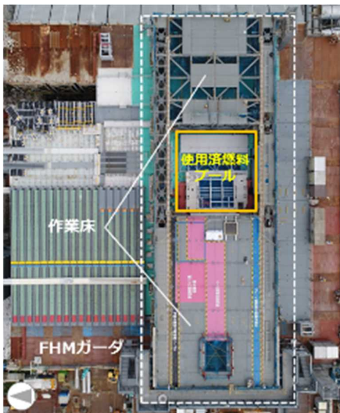
3号機原子炉建屋オペフロ全景 (5月18日時点)
