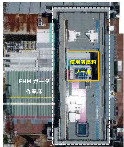
3号機原子炉建屋オペフロ全景 (6月9日時点)
