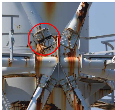
東面(GL+45m付近)
