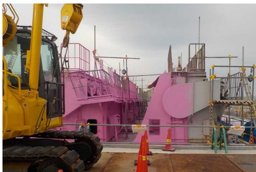
集水タンク増設（2号機除塵機撤去前）
