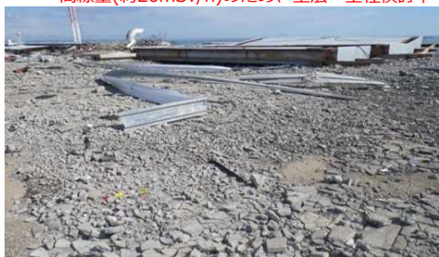
【参考】3号機T/B屋上
