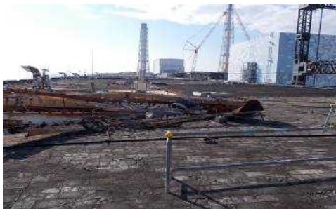
【施工前】1号機T/B屋上
