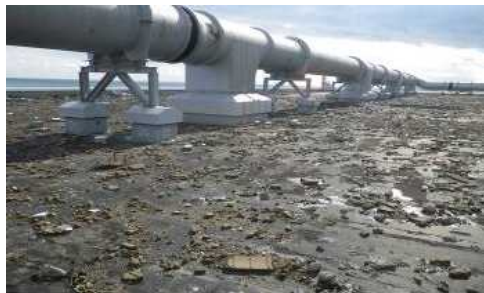
【施工前】4号機T/B屋上
