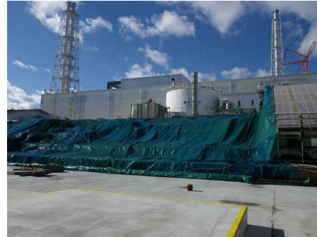
7.5m盤法面シート架け
