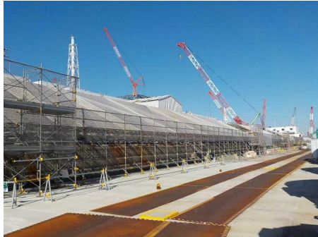
7.5m盤法面屋根架け
