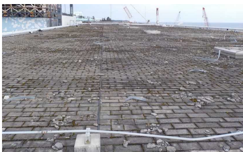
【施工前】2号機T/B屋上
