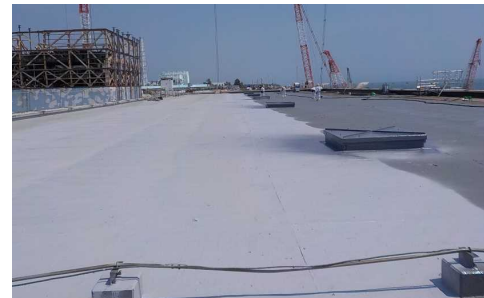
【現況】2号機T/B屋上
