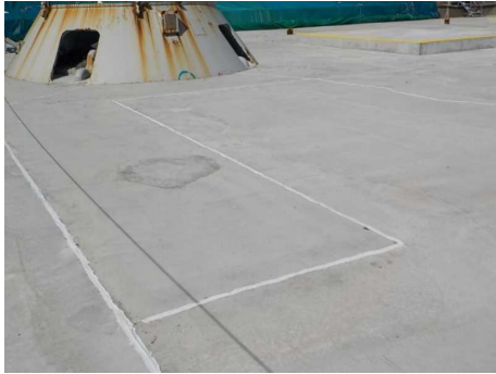
4m盤フェーシング継手止水
