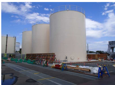
一時貯水タンク増設
