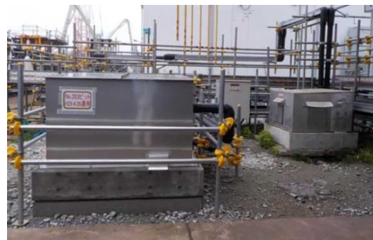
新設ピット増強（順次施工中）
