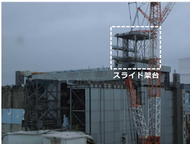
3号機原子炉建屋オペフロ全景 (7月26日時点)
