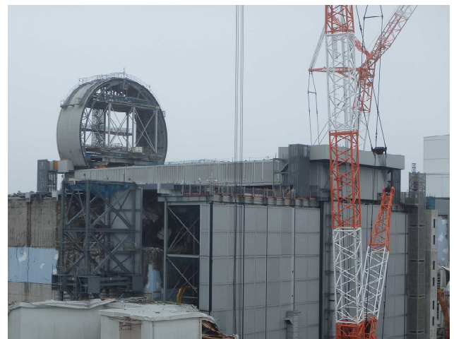
3号機原子炉建屋オペフロ全景 (8月5日時点)
