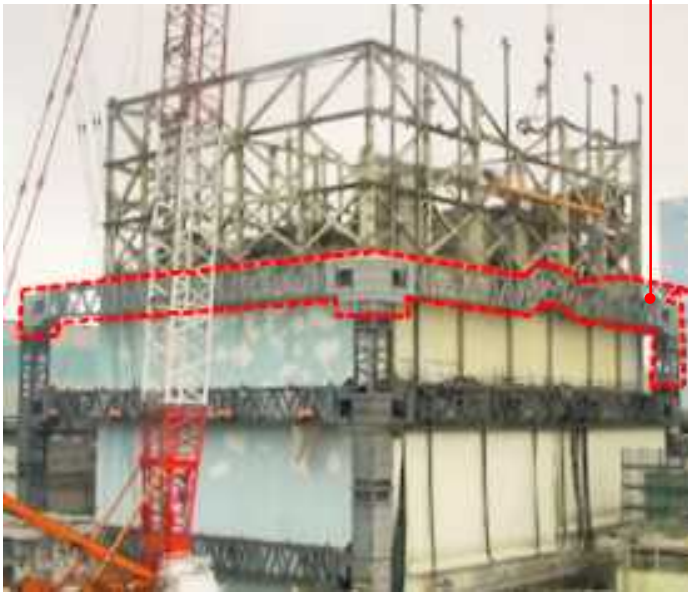
建屋カバー柱・梁取付状況 撮影：H29.10.11
