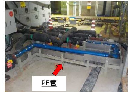
新規P E管施工後
