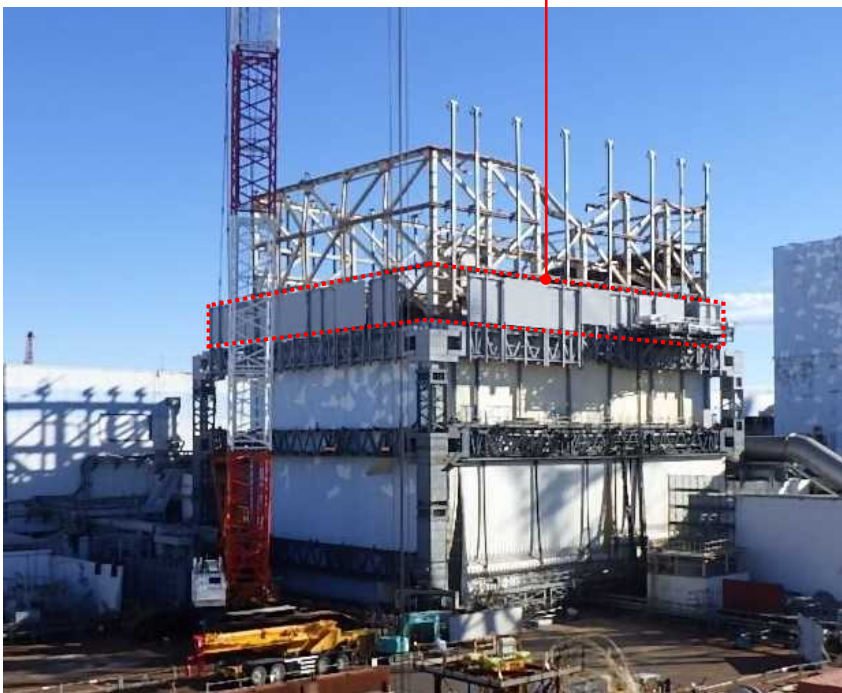
防風フェンス取付状況 撮影：H29.11.28
