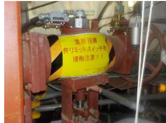
＜注意喚起表示取付け状況＞
