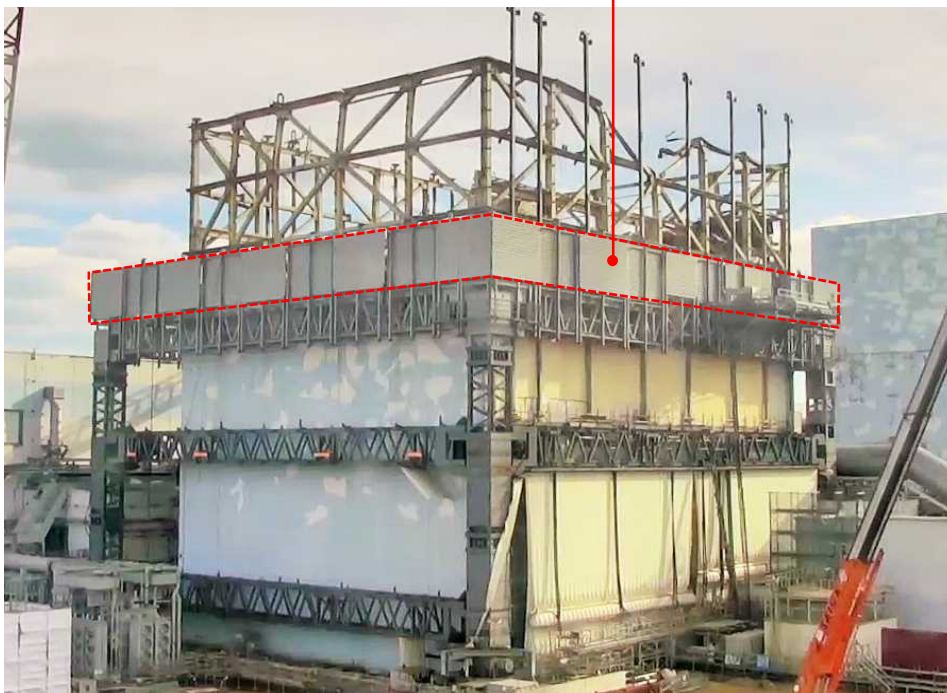
防風フェンス取付状況 撮影：H29.12.19
