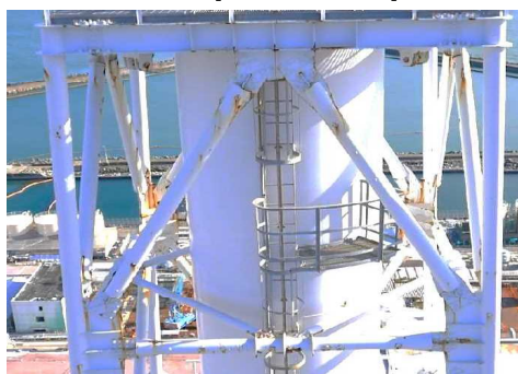
④西側(GL111m付近)
