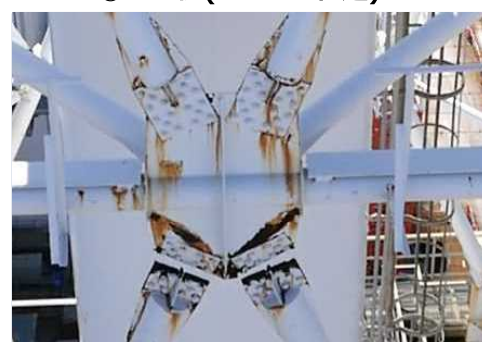
③北側(GL66m付近)
