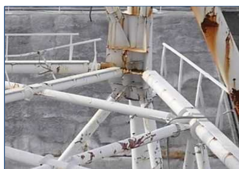
①北西側(GL30m付近)
