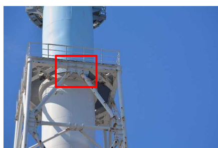
点検写真(a部)
