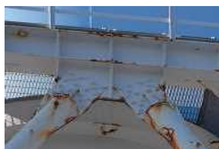
点検写真(a部拡大)
