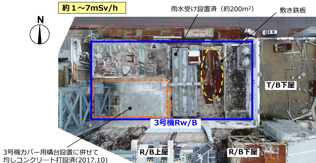
3号機Rw/B屋根の状況
