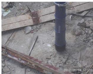
吸引機によるガレキ撤去の様子 (1号機)
