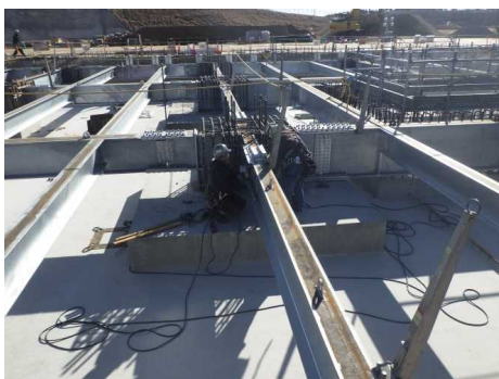
① 1階鉄骨梁設置
