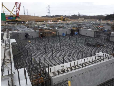
② マットスラブ配筋
