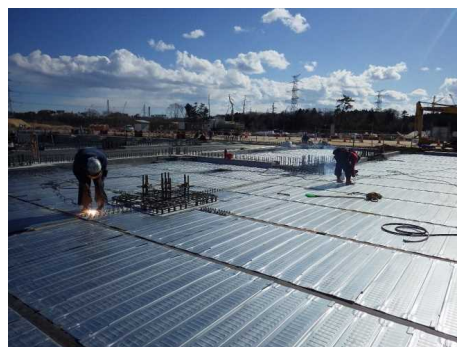
③ 1階床デッキ設置
