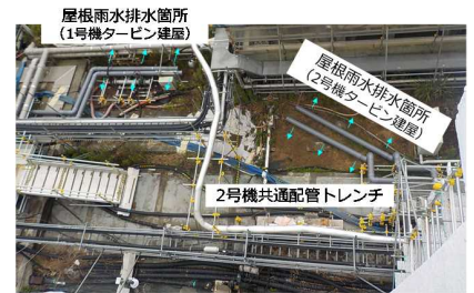
1,2号機タービン建屋の屋根雨水排水箇所の状況
