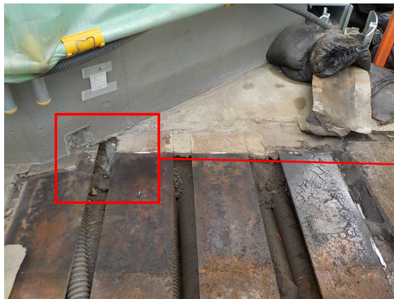
写真-1 (敷鉄板撤去状況写真)
