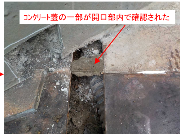
写真-2 (開口部拡大：コンクリート蓋)
