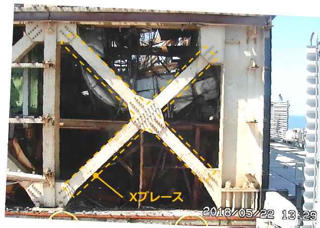
2018年5月 (支障物撤去着手後)
