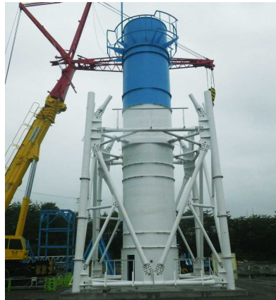
試験体 設置作業状況 (6/15時点)
