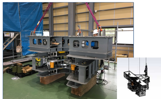
鉄塔解体装置(主柱材用)組立状況
