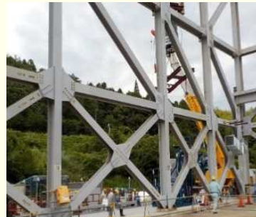
モックアップ試験の状況
