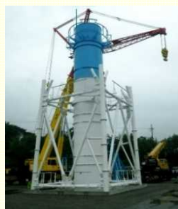
排気筒模擬施設
