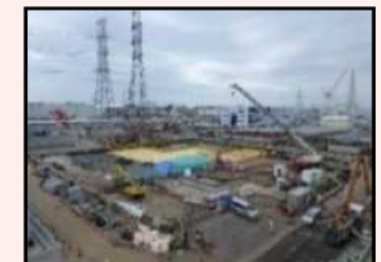
H1東エリア解体後の様子
