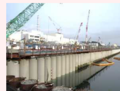
海側遮水壁 鋼管矢板打設完了状況
