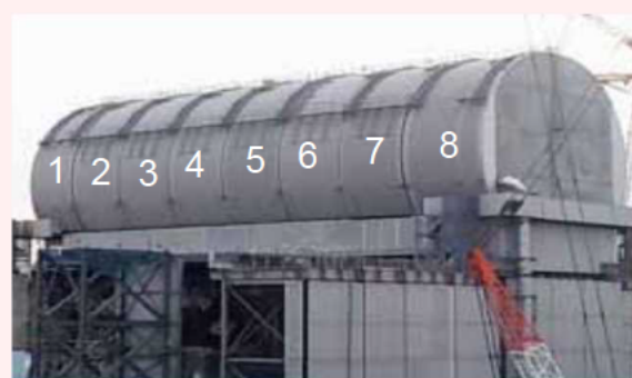
ドーム屋根設置状況（2/21撮影）
