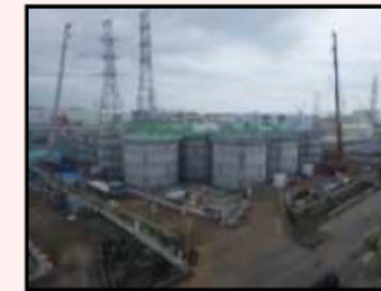
H1東エリア解体開始時の様子
