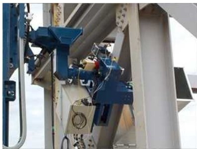
セーバーソーによる切断
