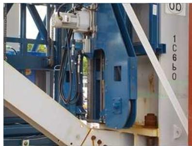
バンドソーによる切断
