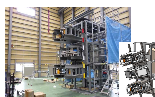
鉄塔解体装置（斜材用）組立状況
