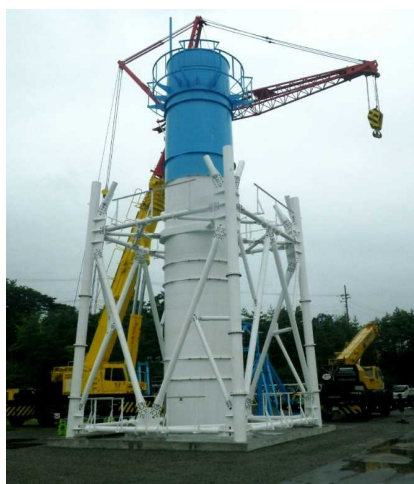
排気筒模擬施設 設置作業状況 (6/15設置完了)
