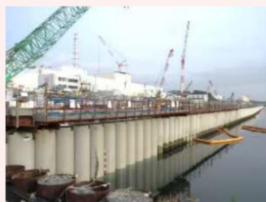
海側遮水壁 鋼管矢板打設完了状況
