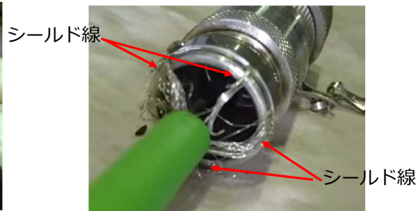
②シールド線状況
