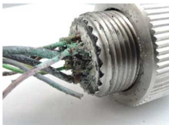
①接続部外観
