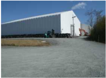
瓦礫保管テント
