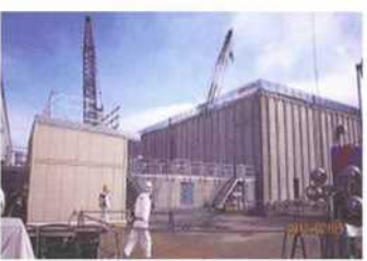
廃スラッジ一時保管施設
