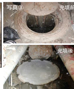
2号機取水電源ケーブルトレンチ貫通箇所 止水状況（写真②）、充填状況（写真③）
