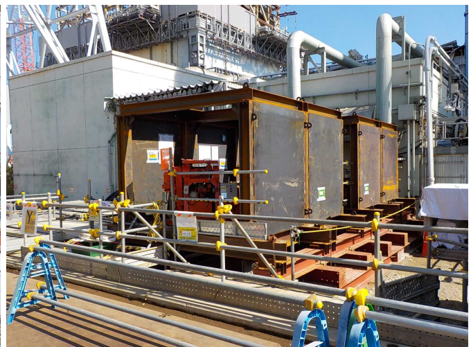
南側：削孔・注入架台設置完了 10/12：削孔・注入開始 10/24：注入実施中
