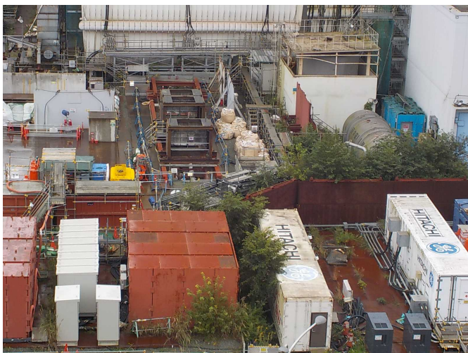
北側：削孔・注入架台設置完了 10/24：削孔準備中 （注入開始：10月末予定）
