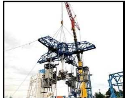
クロスハンガー吊り上げ状況
