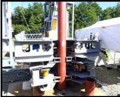
支柱切断装置切断状況
