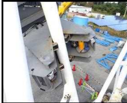
斜材切断装置切断状況
