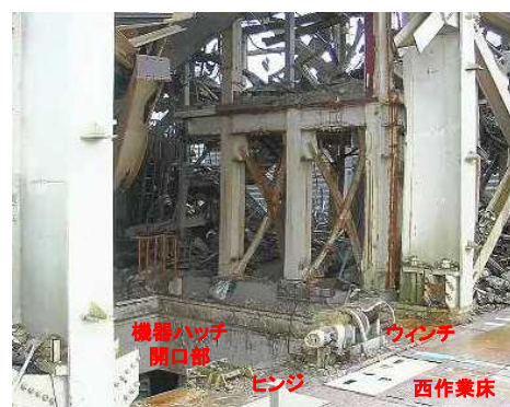
機器ハッチの状況（西作業床より）
